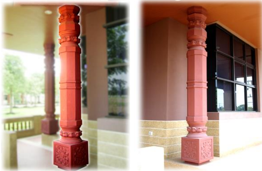
ภาพที่ ๒๒ : เสามุมอาคาร
